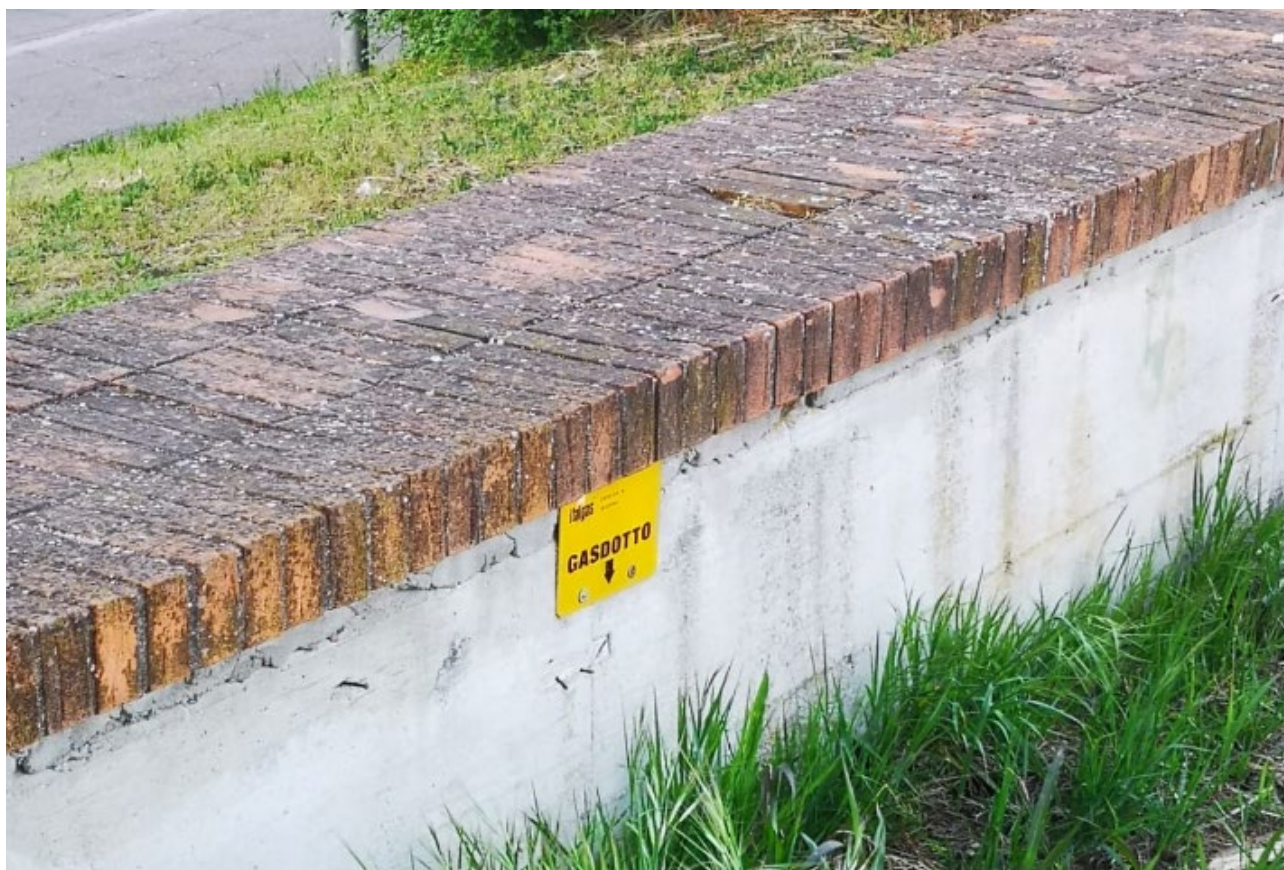
Figura 16.4: Particolare gasdotto esistente muro d'argine sponda sinistra
